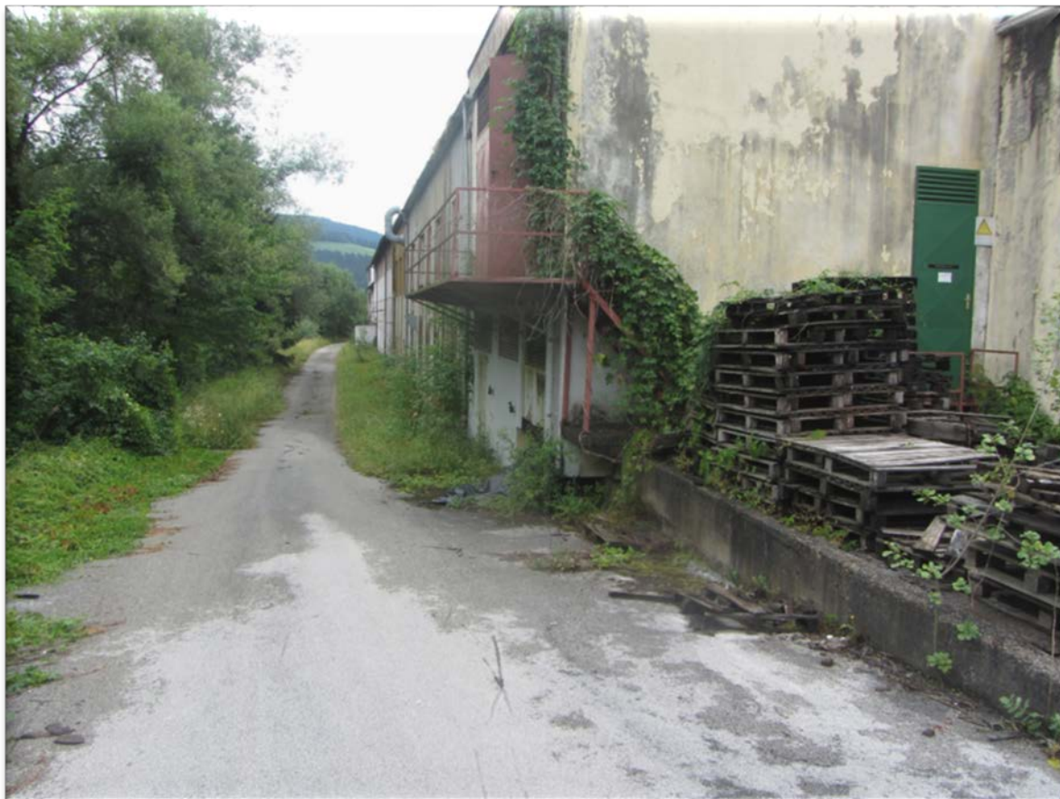
Obstoječe stanje pred izvedbo del.
