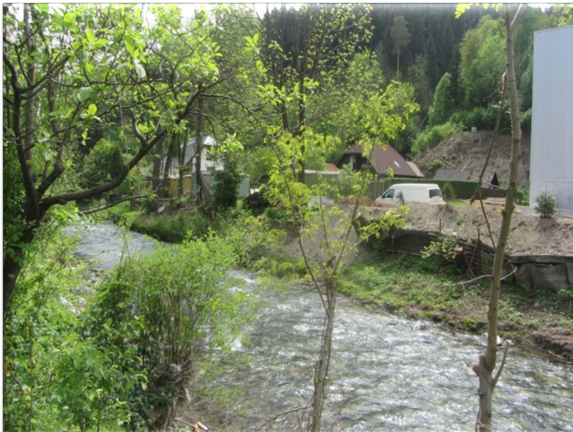
Stanje pred izvedbo del.
