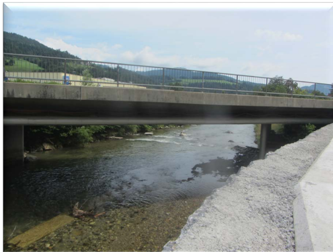
Izveden desnoobrežni protipoplavni zid v območju mostu.
