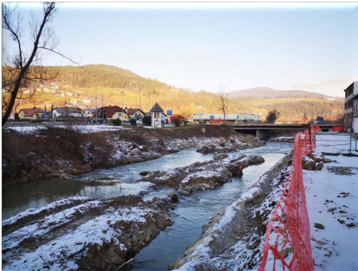
Izvedba spodnje masivne desnoobrežne zložbe.
