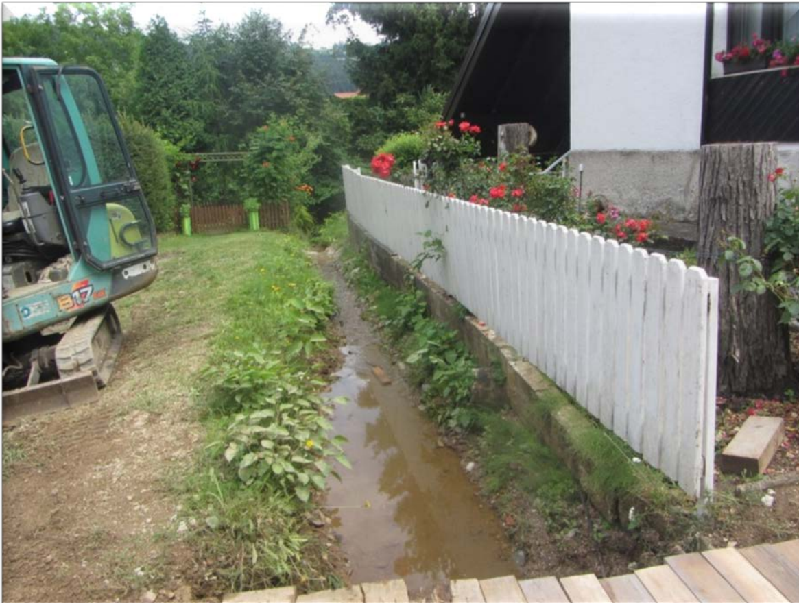
Stanje pred izvedbo del.
