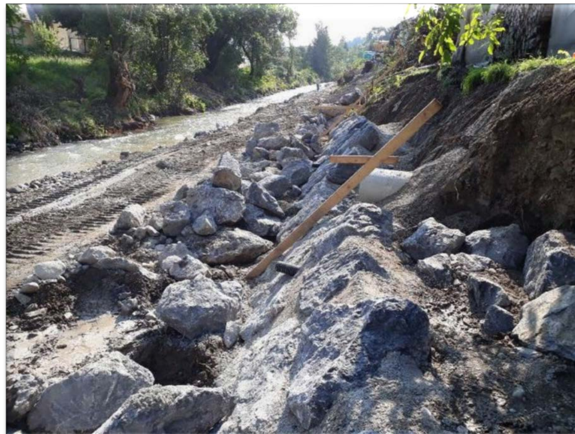
Stanje med gradnjo spodnje zložbe pri hiši Nicina 15.
