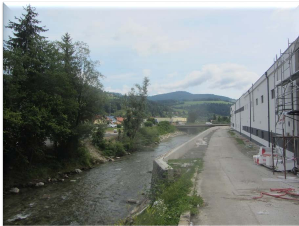
Izveden desnoobrežni protipoplavni zid na odseku 3.
