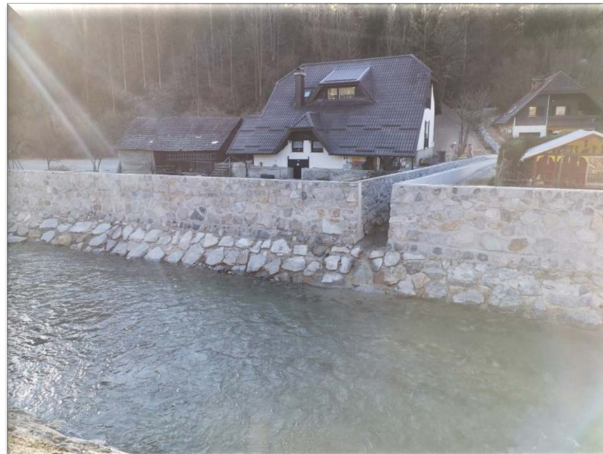
Izvedena protipoplavna zaščita v območju iztoka Gutmanovega potoka.
