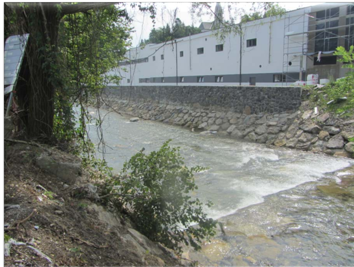
Izveden desnoobrežni protipoplavni zid in ustalitven prag iz kamna v betonu na odseku 3.
