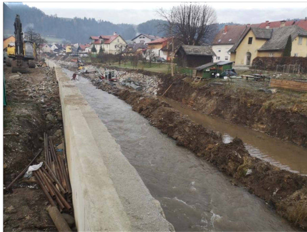
Izkop in izvedba levoobrežne kamnite zložbe v suho na odseku 1.
