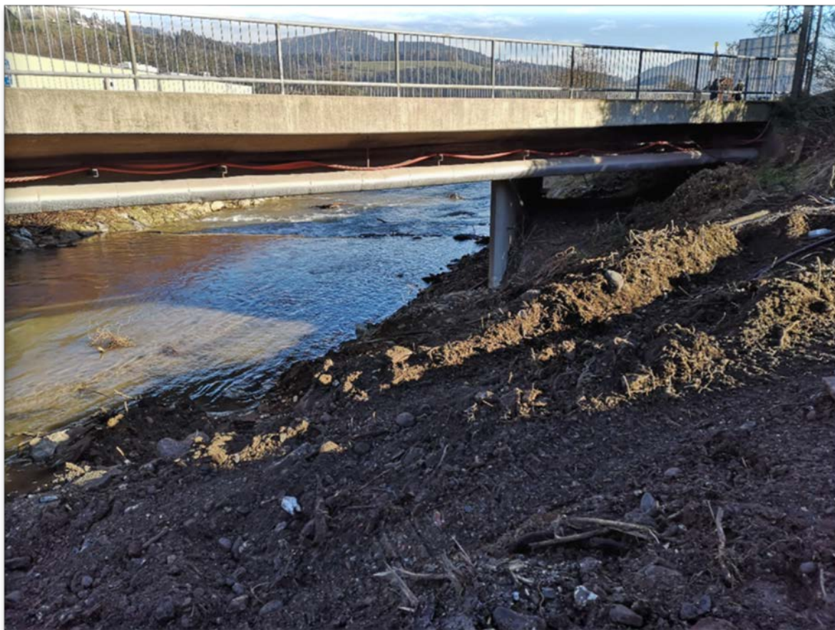
Zemeljska dela v območju mostu.
