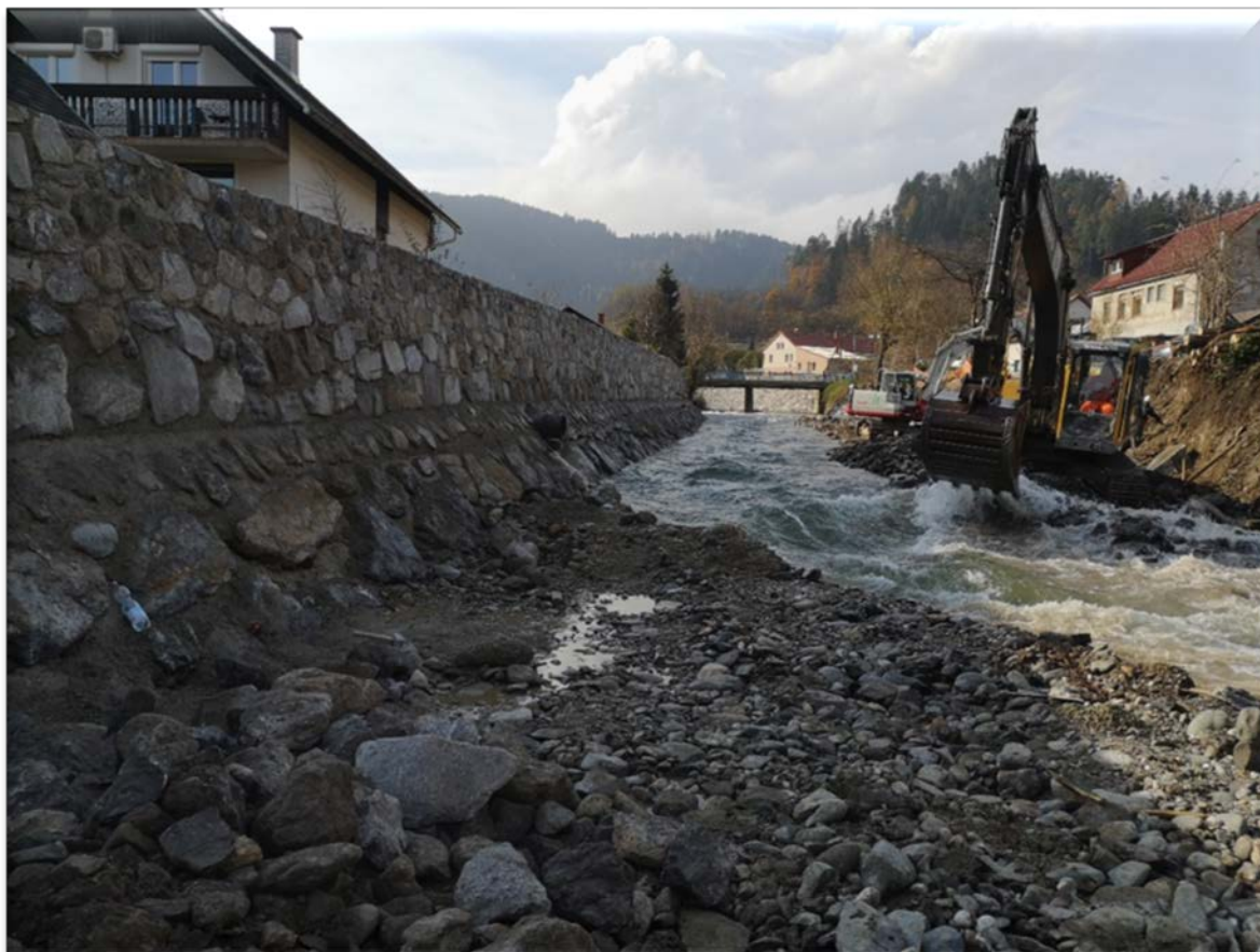
Izkop za ustalitven prag na odseku 1.
